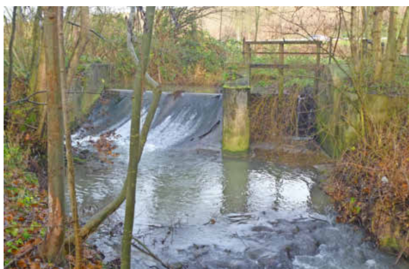
Das Wehr „Böllinger Mühle“ stellt die größte ökologische Beeinträchtigung am Böllinger Bach dar. Im Zuge der Renaturierung wird es jetzt rückgebaut.
