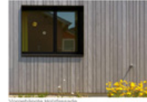
Vorgehängte Holzfassade
