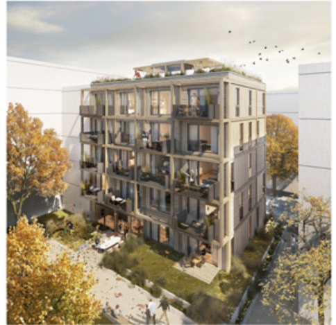
Blick aus dem Innenhof
