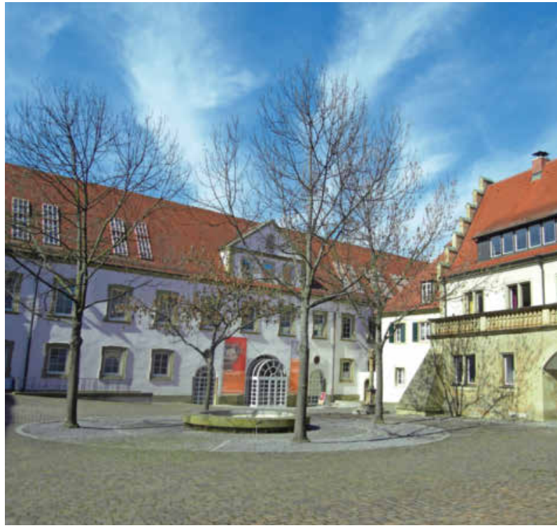
Das Dachgeschoss der Städtischen Museen im Deutschhof wird saniert. Dort entsteht das Studio Vogelmann. Foto: Andrea Golowin
