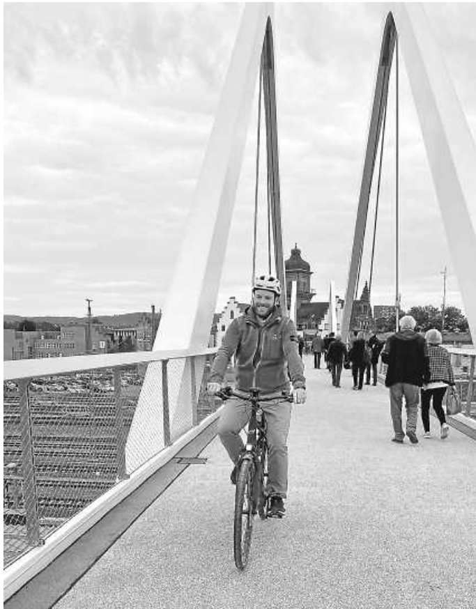
Fahrradfahrer sowie Fußgänger nutzen die Buga-Brücke als direkte Verbindung vom Heilbronner Hauptbahnhof auf den Neckarbogen Foto: Foto: Stadt Heilbronn
