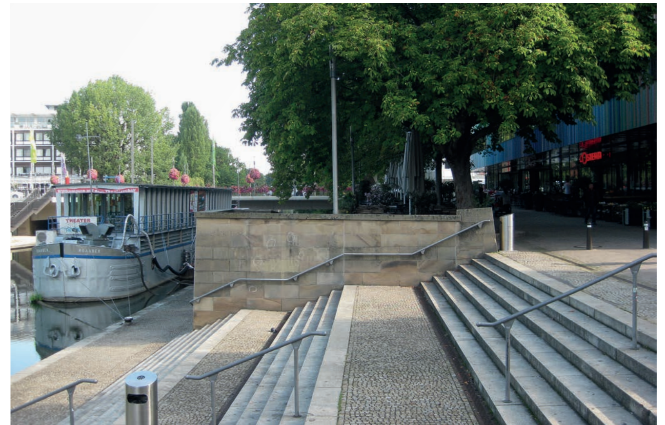
Neckartreppen und Theaterschiff an der Oberen Neckarstraße
