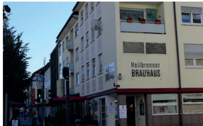
Typische Gebäudenutzungen in der Kirchbrunnenstraße und Allee © Stadt Heilbronn
