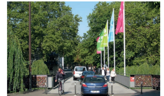
Verkehr auf der Götzenturmbrücke © Stadt Heilbronn
