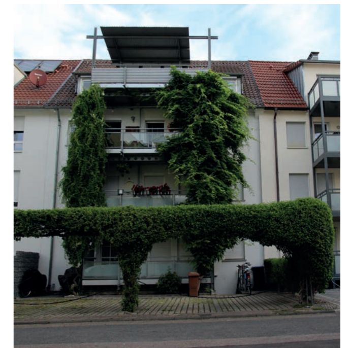
Begrünte Fassade an der Endgasse: Vorbildfunktion für weitere Begrünungsmaßnahmen in Innenhöfen © Stadt Heilbronn
