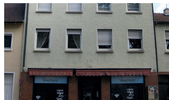
Ungedämmter Gebäudebestand in der Turmgasse und der Zehentgasse © Stadt Heilbronn
