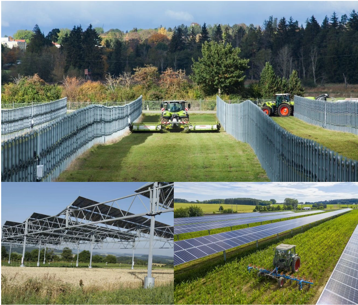
Abbildung 6-12: Beispiele für unterschiedliche Bauformen von Agri-PV Anlagen; oben: bodennahe Systeme, Bewirtschaftung zwischen den Agri-PV-Anlagen; unten links: hoch aufgestellte Systeme, Bewirtschaftung unter den Agri-PV-Anlagen; unten rechts: hoch aufgestellte Systeme, Bewirtschaftung zwischen den Agri-PV-Anlagen (Fraunhofer ISE, 2022)
