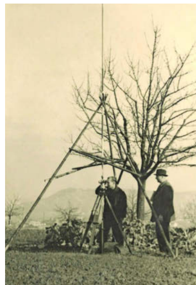
Gegenseitige Signalbeobachtung mit Theodolit und Signalisierungsgestänge 1936 in der Nähe von Sontheim.
