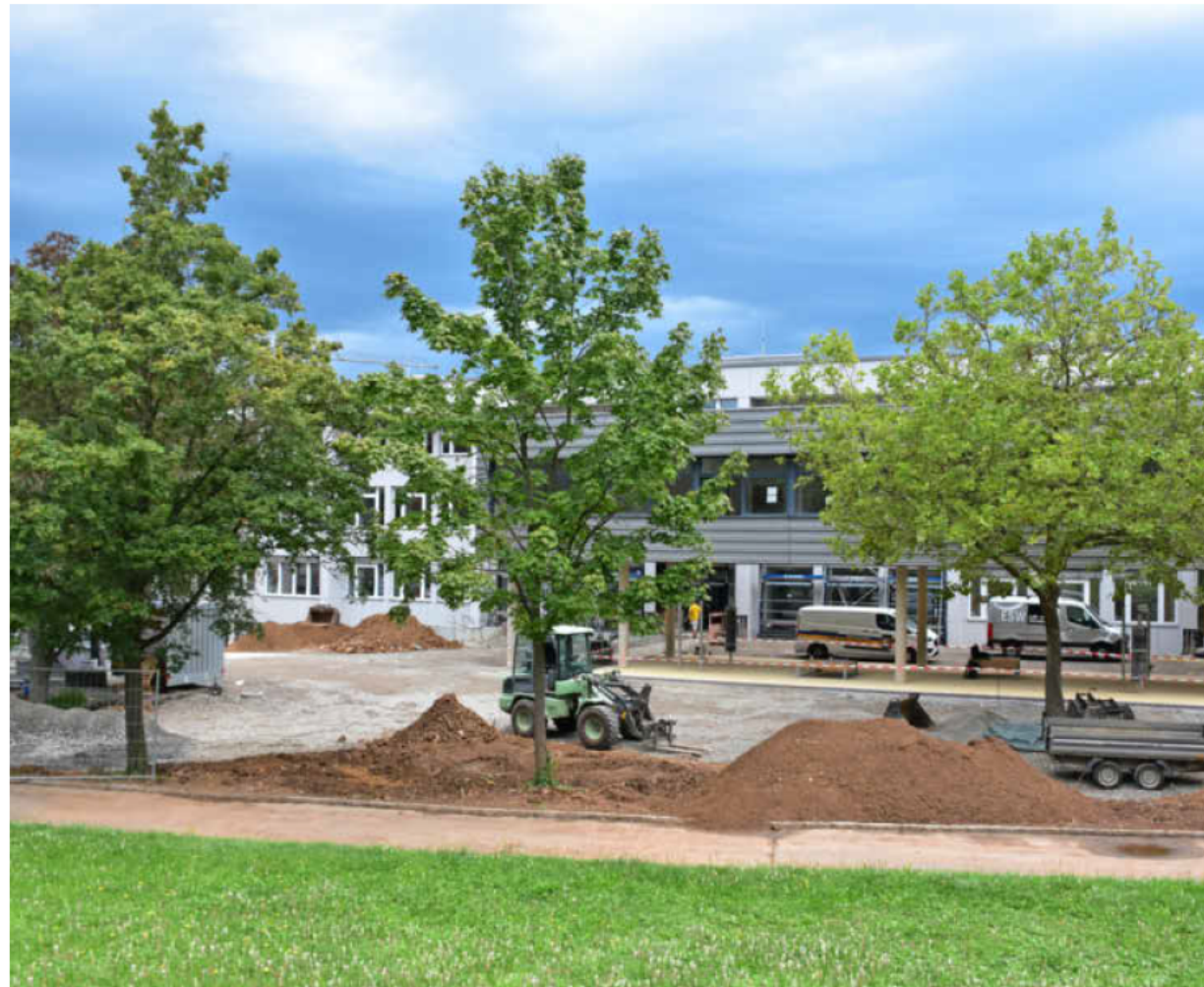
Drei Jahre lang wurde die Fritz-Ulrich-Gemeinschaftsschule umgebaut.
