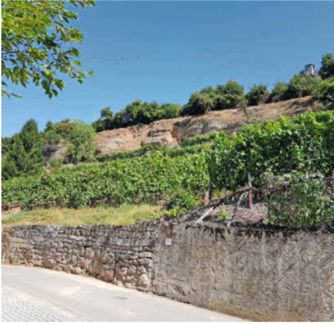
Naturdenkmal und Klingenberg Wahrzeichen: Die Nagelfluh-Felsenkette muss gesichert werden. Foto: Archiv/Stadt Heilbronn
