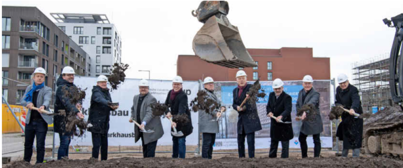
Spatenstich mit Oberbürgermeister Harry Mergel (4.v.r.) und Verkehrsminister Winfried Hermann (5.v.r.) für eine hochmoderne E-Quartiersgarage im Neckarbogen. In voraussichtlich einem Jahr soll sie fertig sein. Foto: Stadtarchiv Heilbronn/B. Kimmerle
