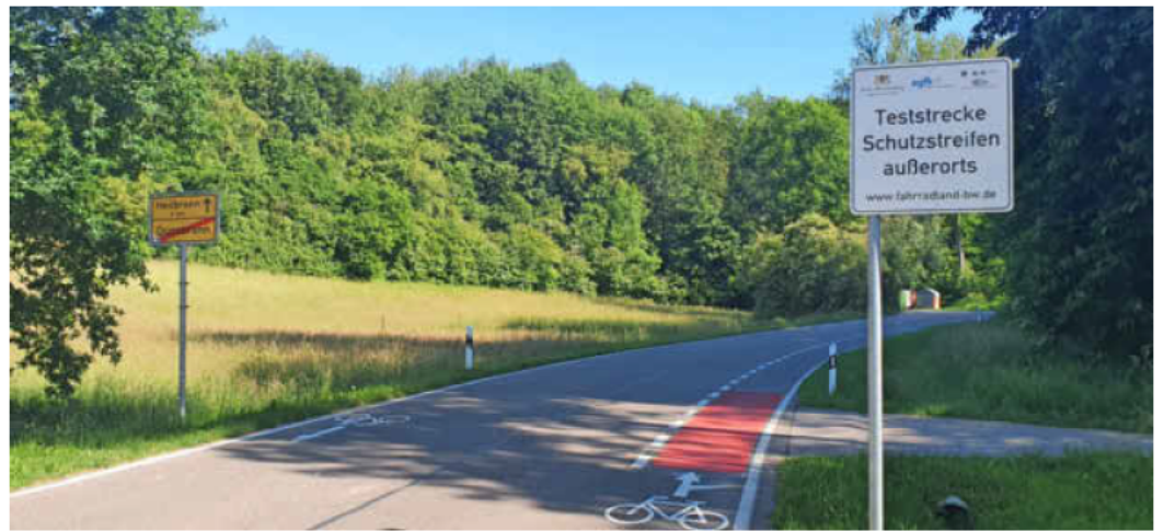
Im Heilbronner Stadtwald wurde über das Jägerhaus und die Waldheide ein außerörtlicher Schutzstreifen bis Ortseingang Donnbronn angelegt. Er wird jetzt beibehalten. Foto: AGFK-BW
