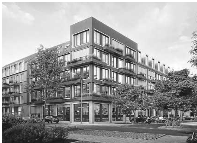
Wohn- und Geschäftshaus „Vinzent“ in München (Quelle: Architekturbüro allmannwappner)
