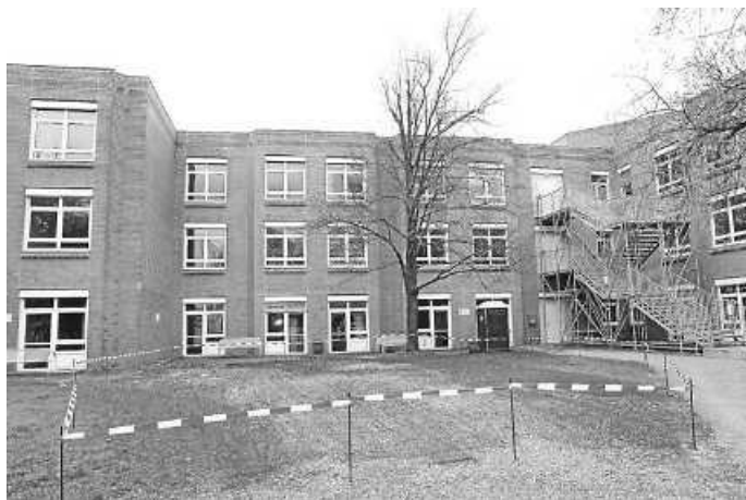
Außenansicht der neuen Gemeinschaftsunterkunft in einem leer stehenden Trakt des SLK-Altbaus
